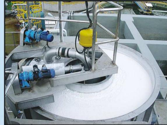
加壓浮除池 Dissolving Air Flotation
