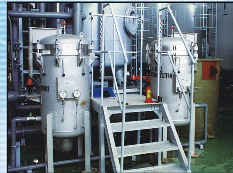
精密過濾器(純水用) Cartridge Filter
