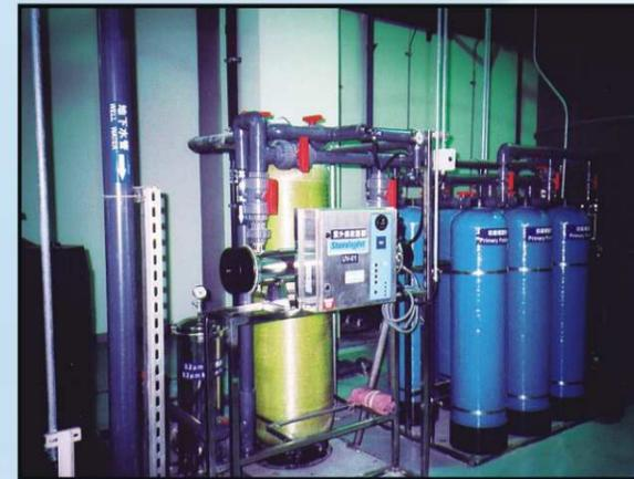
超純水處理系統 Ultra Pure Water Treatment System
