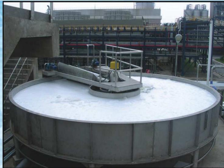
加壓浮除池 Dissolving Air Flotation
