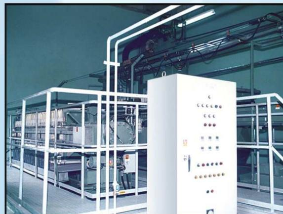
壓濾式污泥脱水機 Filter Press
